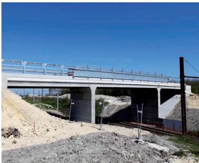
Ci-dessus, un exemple d'ouvrage d'art en construction de la LGV Tours-Bordeaux, réalisé grâce à l'approvisionnement de la carrière GSM.
